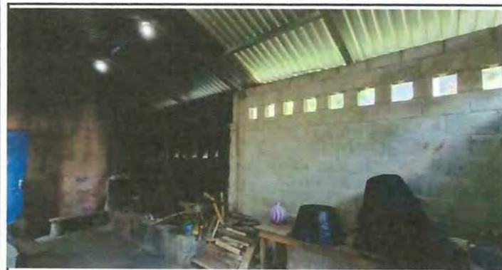
Foto1: Mejoramiento de planchas de cocina.
