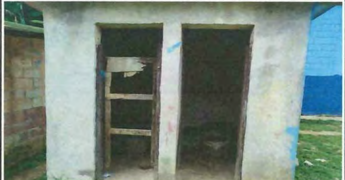
Foto 2: Sustitución de inodoros.
