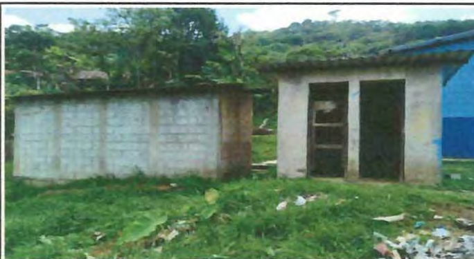
Foto 3: Instalación de lavamanos
