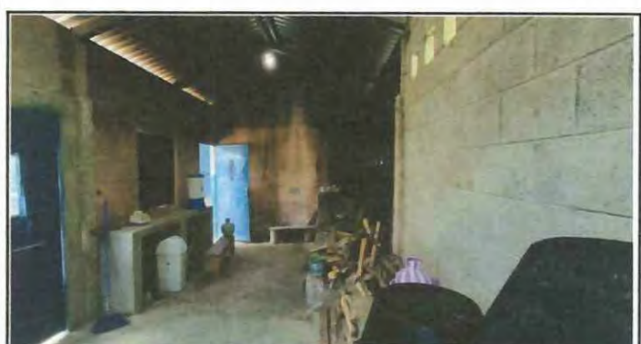
Foto 5: Sellado de grietas y fisuras en muros.
