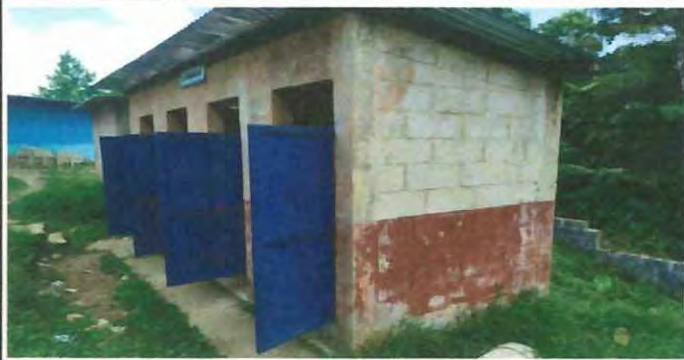
Foto1: Sellado de grietas y fisuras en muros del baños.
